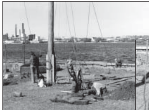
Der graves huller til de nye ankre
